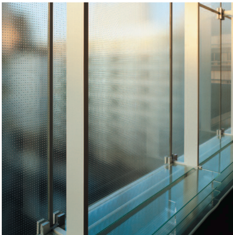
Nihonbashi Yayoi, Tokio, Japón. Arquitecto: A. Kuryu Architect & Associates Co. Ltd.
